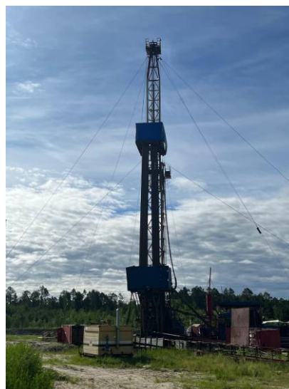
Рисунок 1. МБУ-140 зарезки бокового ствола был создан цементный мост, затем с помощью клина и райзер было забурено окно. Частицы металла, попавшие в скважину, вызвали поломки долота. Бурение производилось пятилопастным долотом PDC диаметром 126 мм.
